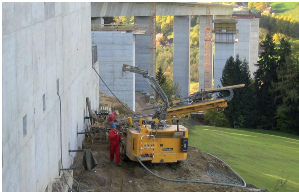
picture: Keller Grundbau
